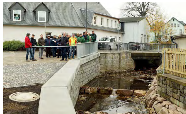
Abbildung 30: Wehrrückbau am Niederen Anger in Zwönitz (Zwönitzer Anzeiger vom 02. Januar 2020)
